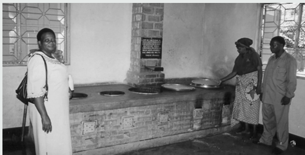
Новая энергосберегающая кухонная плита в чистой школьной кухне. Фото Устойчивый проект Моши
