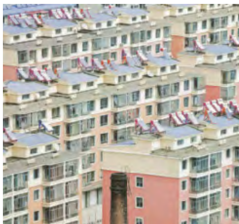
Подогрев воды с использованием солнечной энергии в Хуньчуне (Китай) © UN-Habitat/Alessandro Scotti
