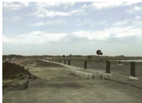
Строительство дороги в Кейптауне, (Южная Африка) © Flickr/Warrenski
